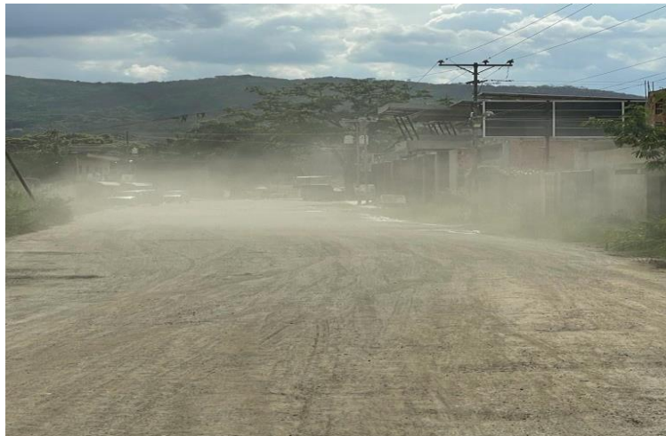
Figura 1. Problemas de generación de polvo
