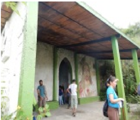
Figura 13. Capilla de Ermita, fachada. Fuente: Google Earth (2018)
