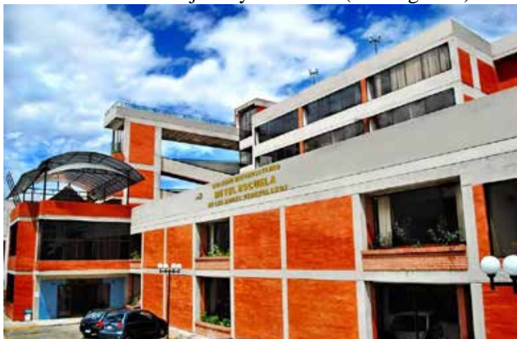
Figura 7. Perspectiva: Vista exterior de la edificación. Fuente: http://www.hotelescuola.org.ve
