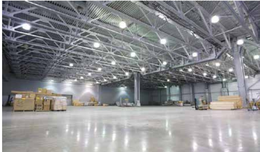
Figura 34: Pisos Concreto Pulido. Fuente: https://construepoxicos.com/tipos-de-pisos-industriales/ (2018)
