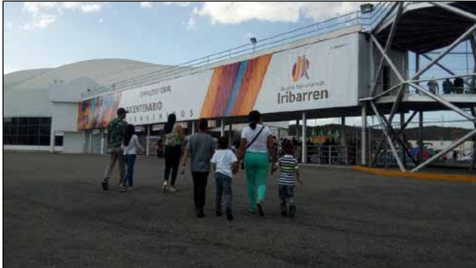
Figura 10: Fachada principal complejo Ferial Fuente: Noticias Barquisimeto (2019)
