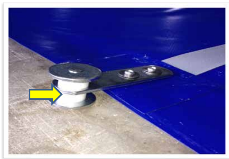
Figura 8. Instalación de garrocha Fuente: Empresa Pexmark, C.A.
