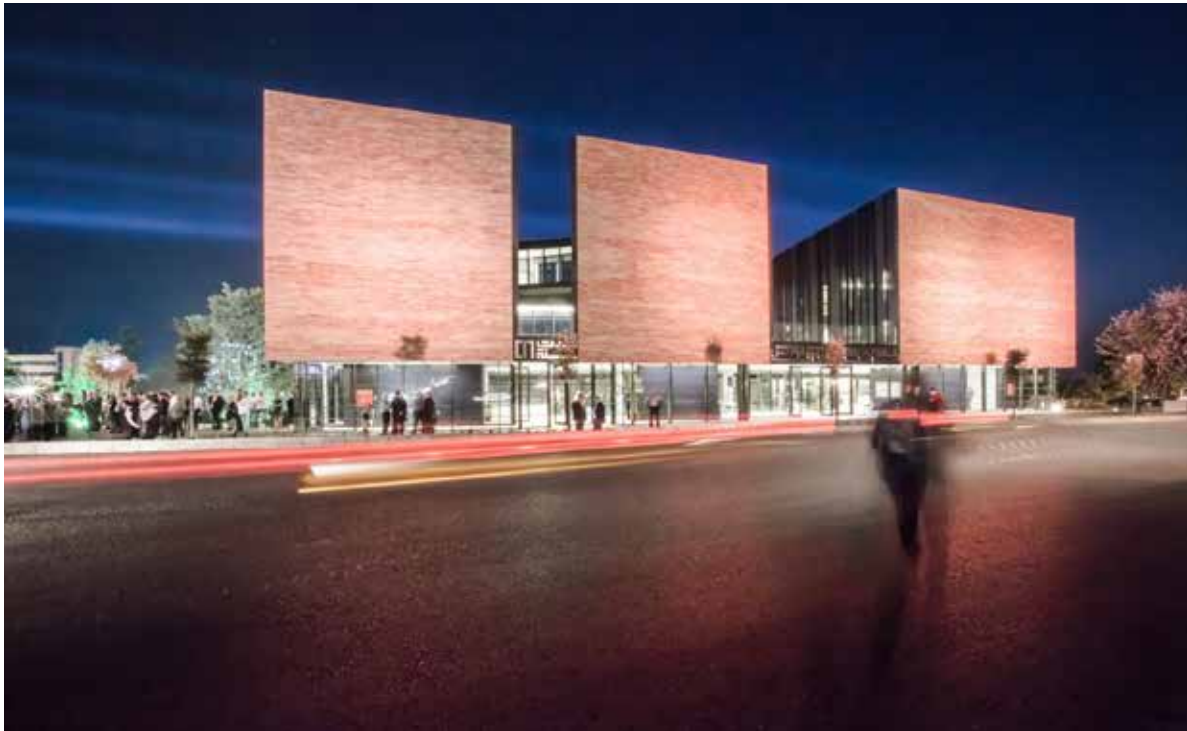
Figura 05. Auyuntamiento de Byblos
