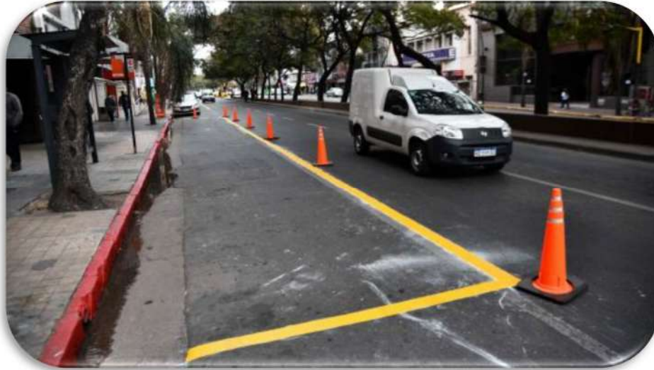
Figura 25. Ejemplo de demarcación
