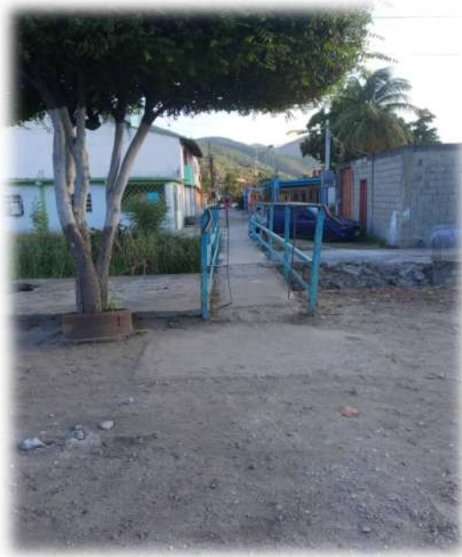
Figura 9. Parada puente azul, Cumboto II Fuente: Heras (2023)
