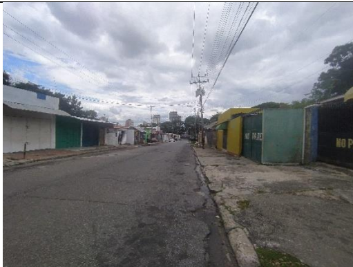
Figura 7. Condición de las calles y la vivienda, Calle 103 Carabobo, los colorados.
