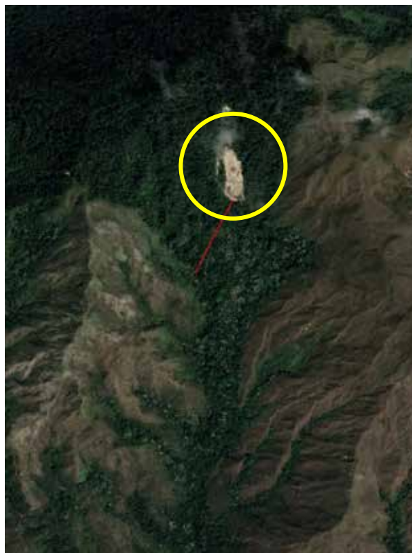
figura 26 : Ubicación de la zona de derrumbe
