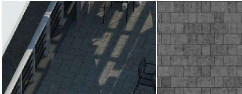
Figura 35 Piso de concreto estampado. Fuente: Cáceres (2021).
