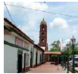
Figura 19 Notaria Única de Puerto Santander, ubicada junto a la Iglesia, Fuente: Google Street View (07/2014)
