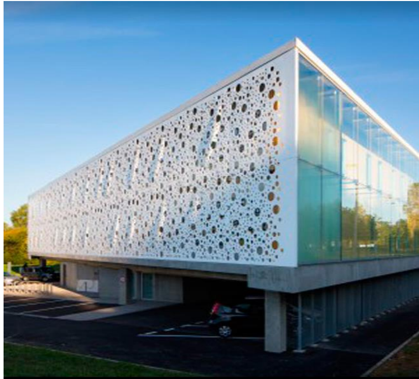
Figura 36. Doble piel- Sistema de Fachadas Ventiladas.
