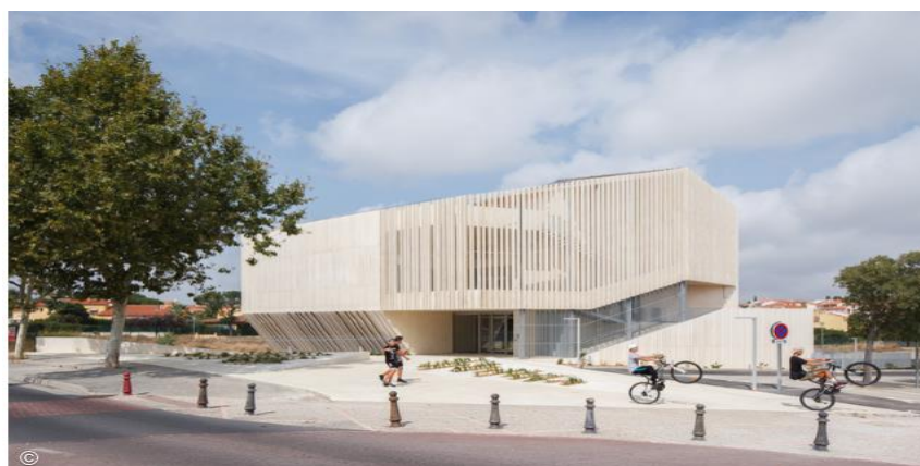
Figura 7: Centro Cultural Guy Môquet. Fuente: https://www.plataformaarquitectura.cl (2020)
