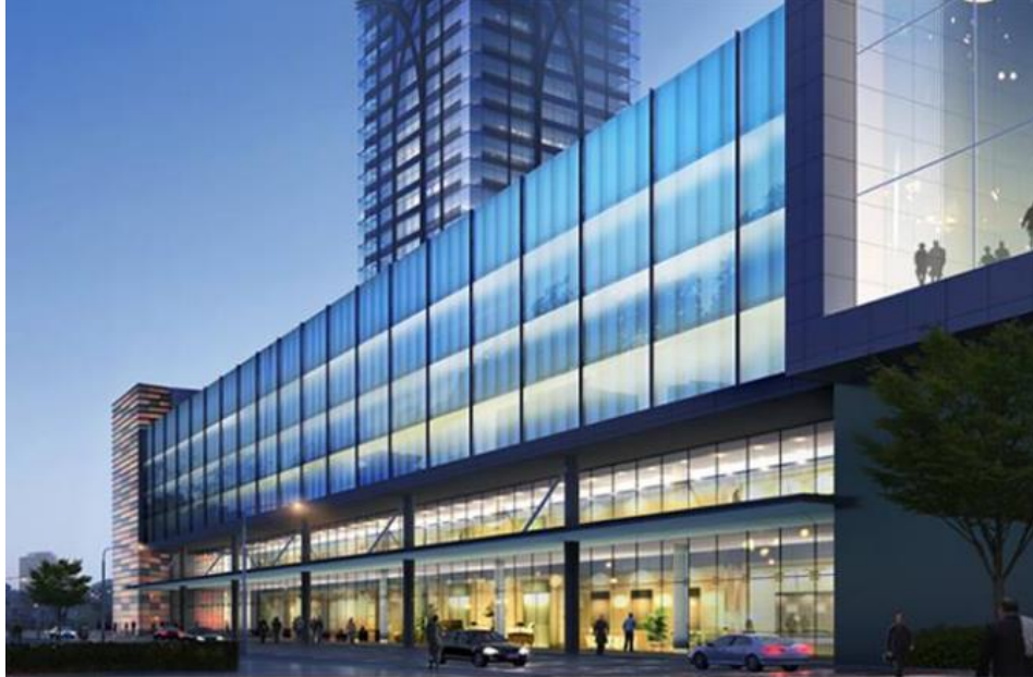
Figura 35. Muro Cortina de Vidrio.
