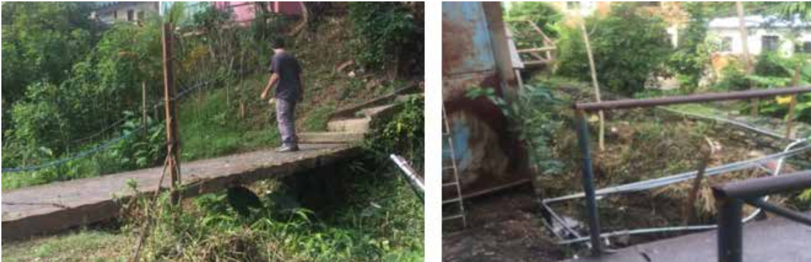
Figura 10. Canales de desagüe y la quebrada.
