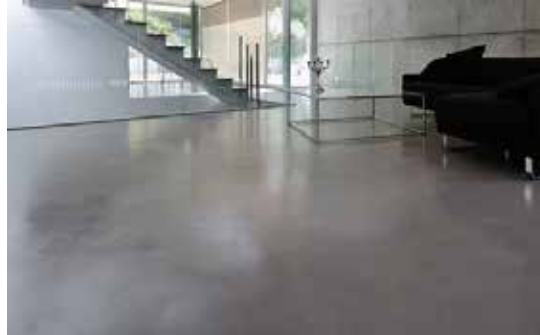
Figura 49. Pisos con microcemento. (2018).
