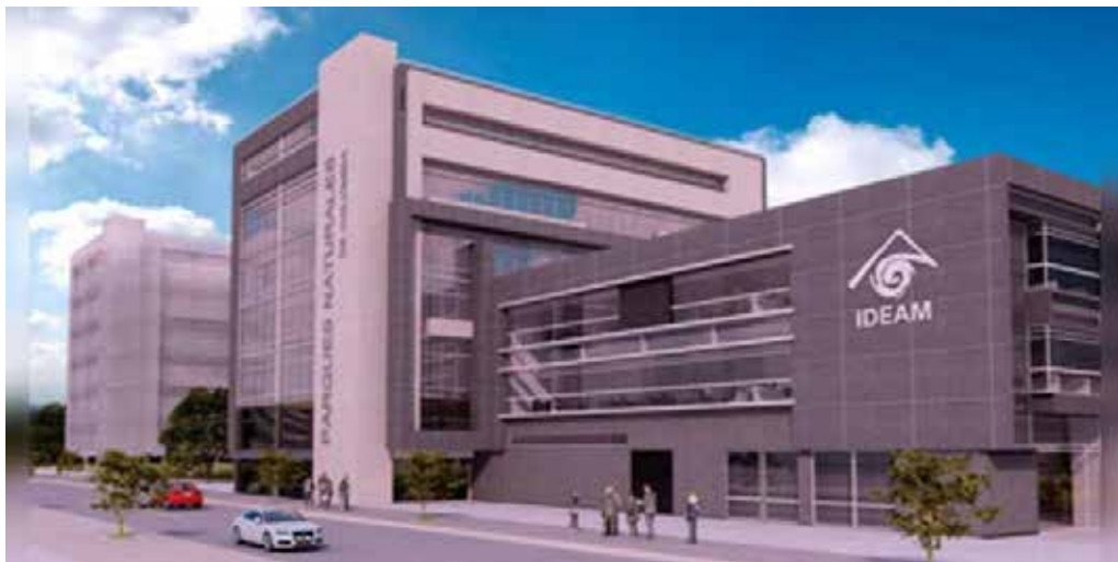
Figura 4: vista del Instituto de Hidrología, Meteorología y Estudios Ambientales, Bogotá, Colombia. (2014)
