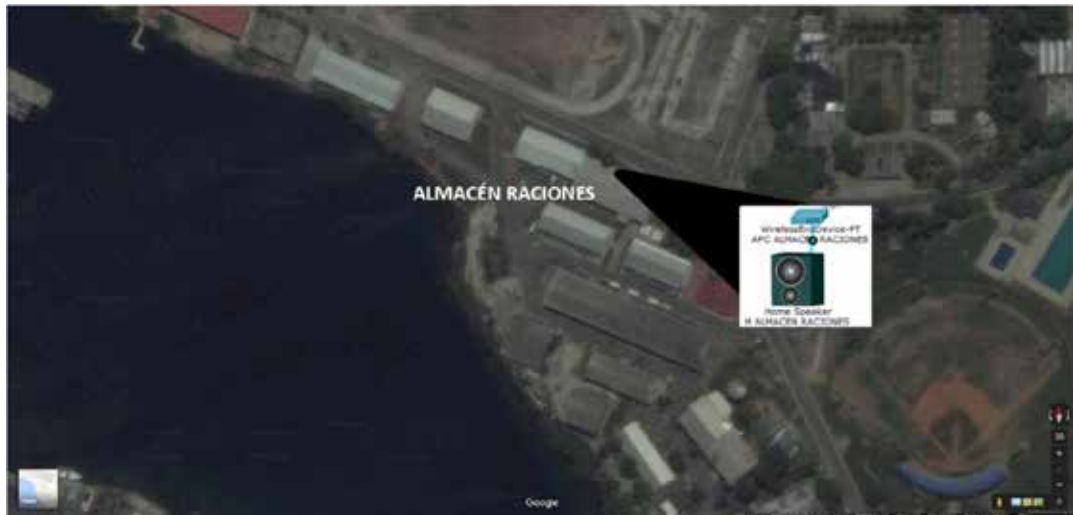
Figura 8: Equipos Almacén Raciones
