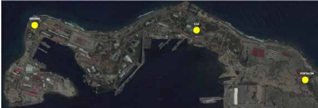
Figura 15: Ubicación de los mástiles de telecomunicaciones
