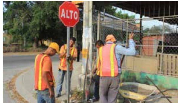
Figura 6: Trabajos de señalización vertical.
