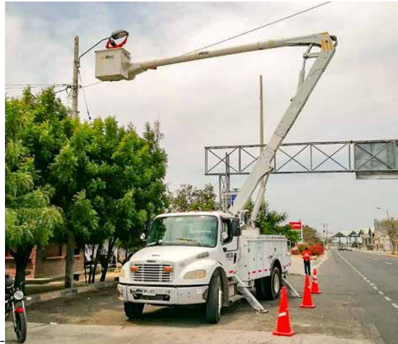
Figura 4: Trabajos de alumbrado público 2.
