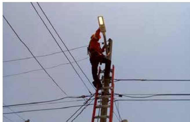
Figura 3: Trabajos de alumbrado público 1.
