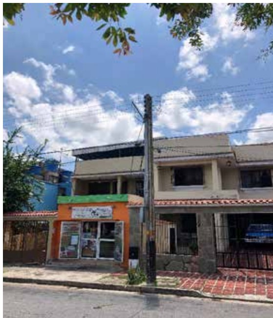
Figura 51: Sistema de iluminación en condiciones precarias.
