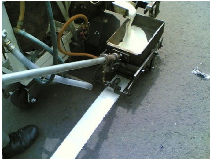
Figura 34: Aplicación de resina termoplástica a calor.
