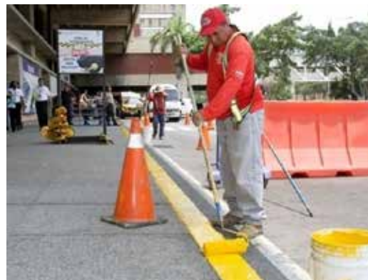
Figura 5: Trabajos de señalización horizontal.
