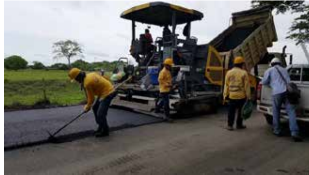
Figura 2: Trabajos en la carpeta asfáltica 2.
