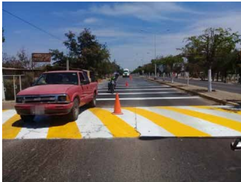
Figura 32: Líneas transversales para demarcar reductores de velocidad.
