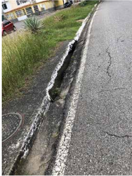
Levantamiento de brocal por raíces:
