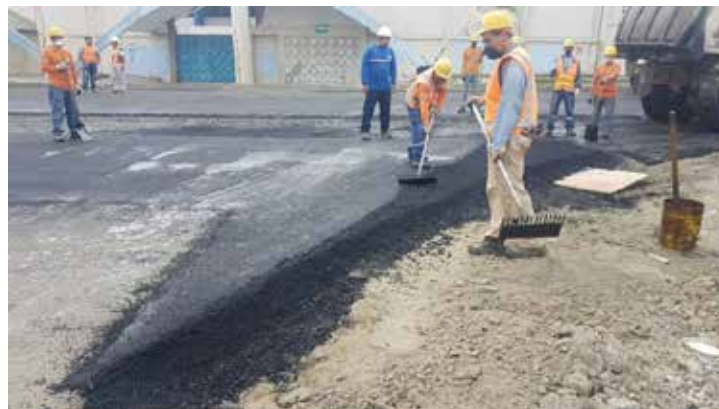
Figura 1: Trabajos en la carpeta asfáltica 1.
