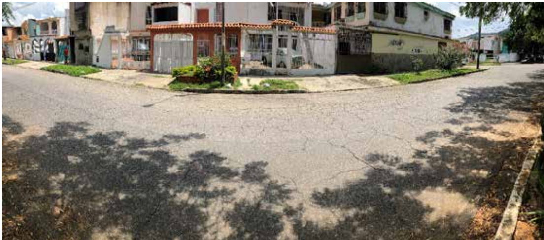
Figura 41: Fisuras de bloque, Calle 179A.
