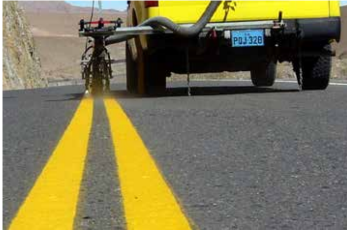
Figura 33: Aplicación de pintura de plástico a presión.
