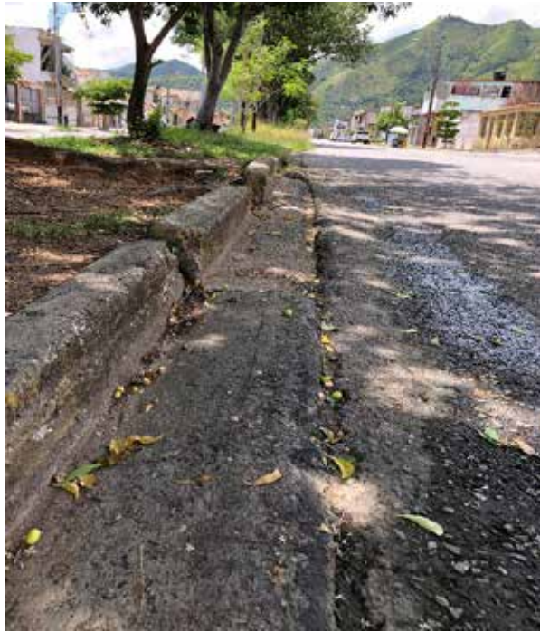
Figura 43: Levantamiento por raíces, Calle 179A.
