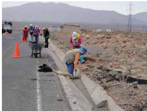
Figura 7: Trabajos de cuidado de cunetas.
