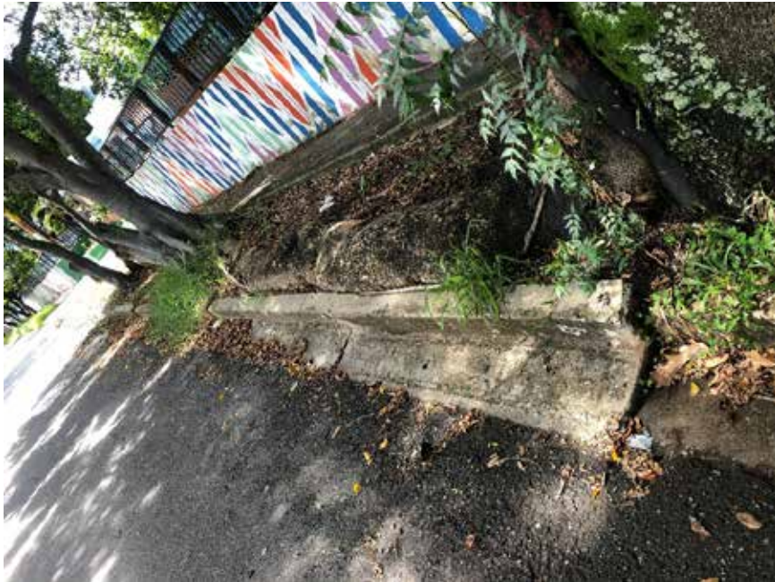
Levantamiento de brocal por raíces:
