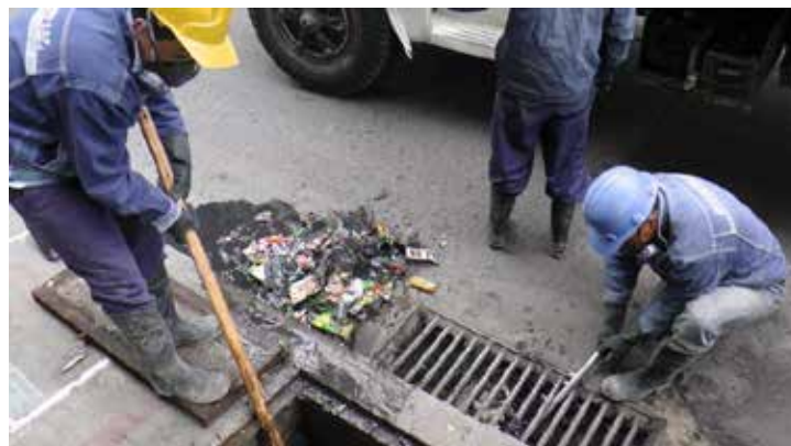
Figura 8: Trabajos de cuidado de sumideros.
