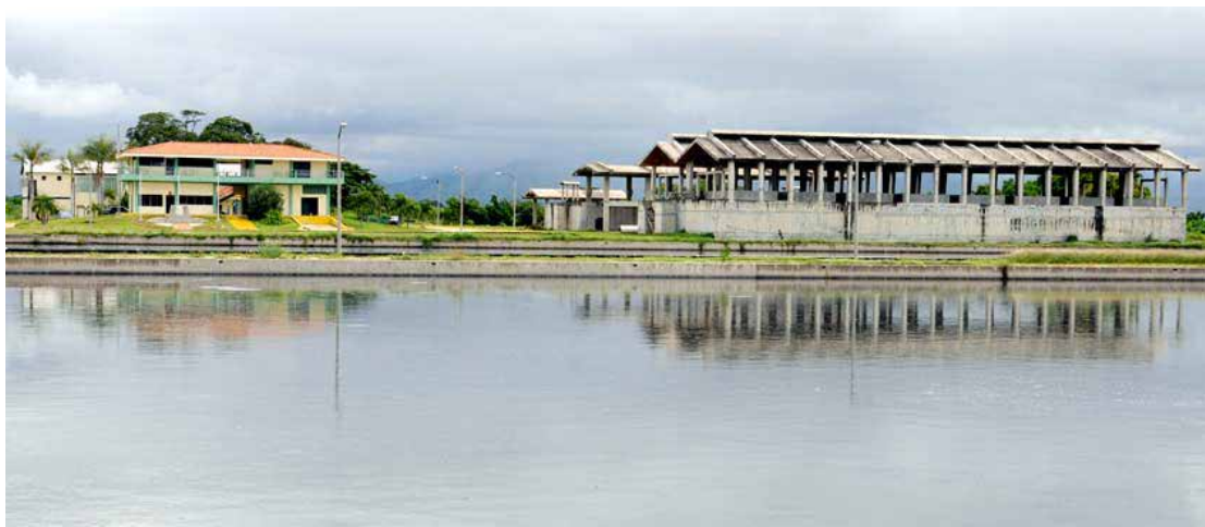
Figura 40. Planta de Tratamiento de Aguas Residuales (PTAR) de Los Guayos.
