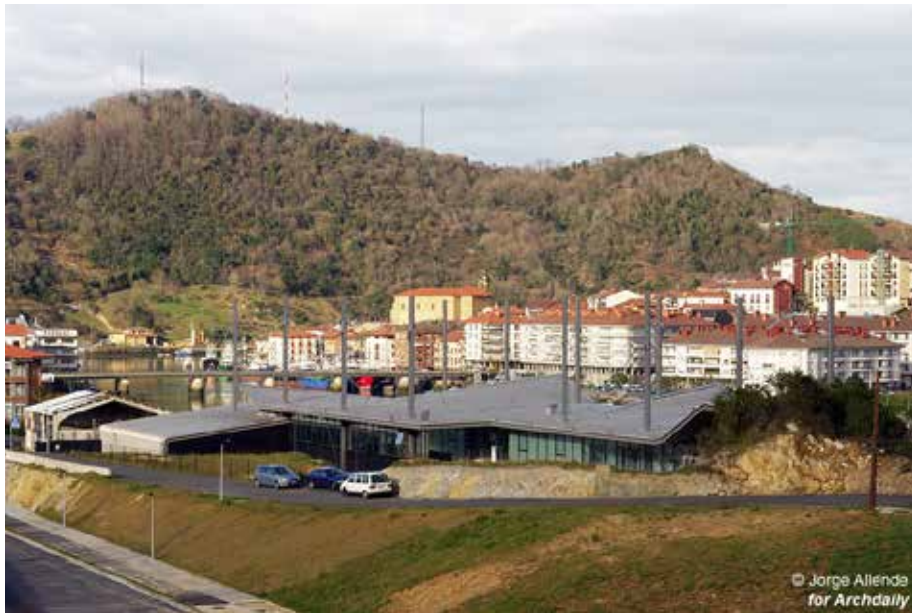
Figura 7. Centro de tecnificación y piragüismo de Orio.
