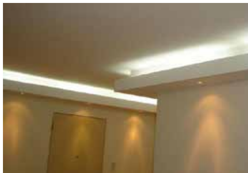
Figura 79. Cielo raso de yeso.
