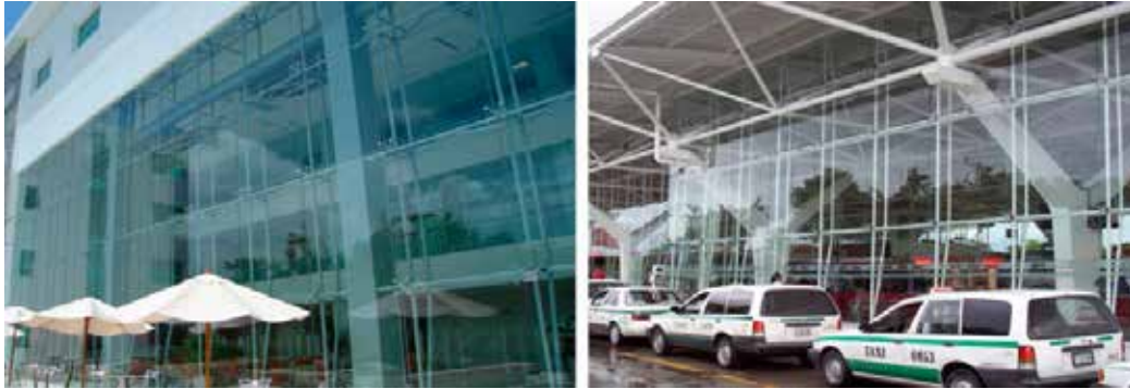
Figura 35: Fachada de vidrio templado con estructura tipo araña. Fuente: http://www.modualuxe.com/aluminio_y_cristal.html (2016).
