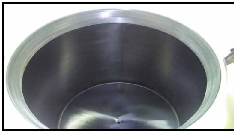
Figura 27. Vista interna del Tanque Fuente: Ronald Stanisavlevich 2017.
