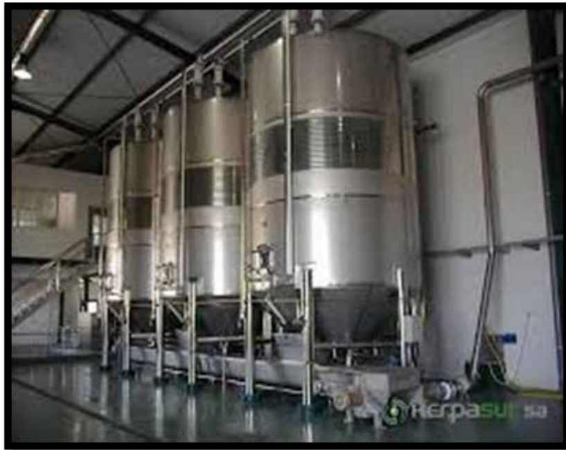
Figura 19. Tanque de Acero Inoxidable.
