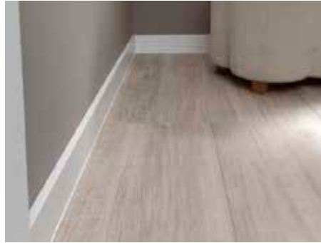
Figura 70. Detalle de Zócalo en Oficinas. Fuente: http://www.archiexpo.es/prod/emacs-complementos-sl/product-59013-1820086.html#product-item_952298 (2017).
