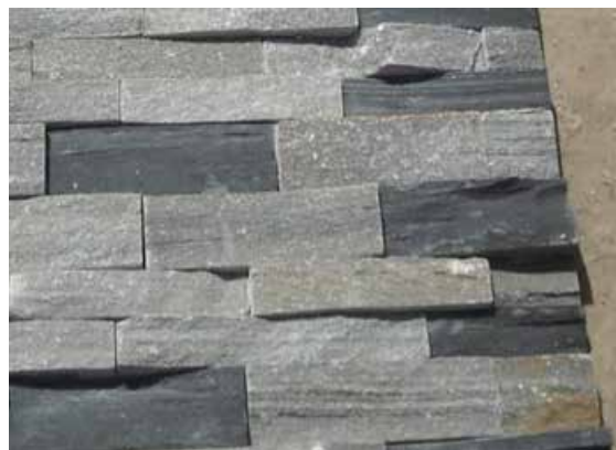
Figura 76. Acabado de semisótano, área de la comisaría. Fuente: https://vietnamese.alibaba.com/product-detail/best-selling-black-slate-bathroom-tiles-60207687390.html (2017).
