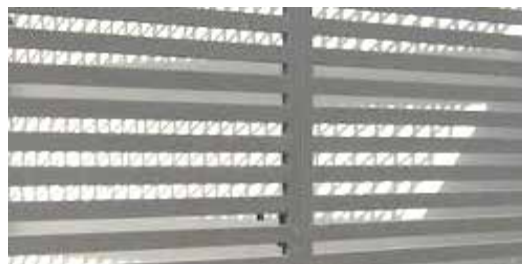
Figura 65. Cerramiento de Fachada para Privados de Libertad. Fuente: https://www.pinterest.com.mx/explore/barandales-de-herreria-modernos/ (2017).
