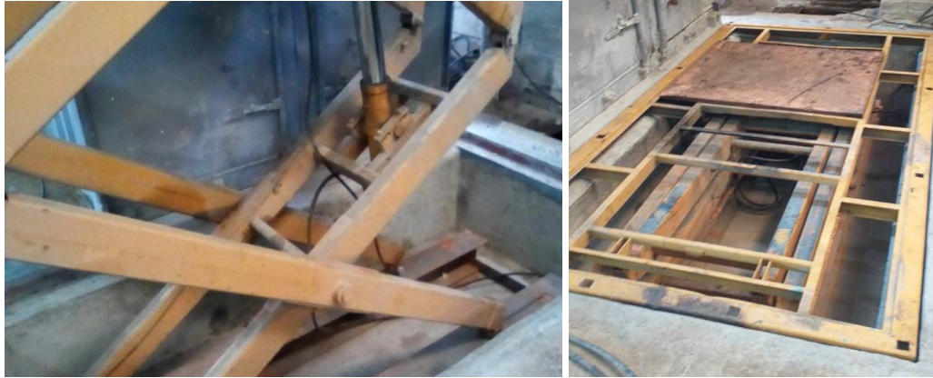
Figura 16: Plataforma y Barras de Soporte.
