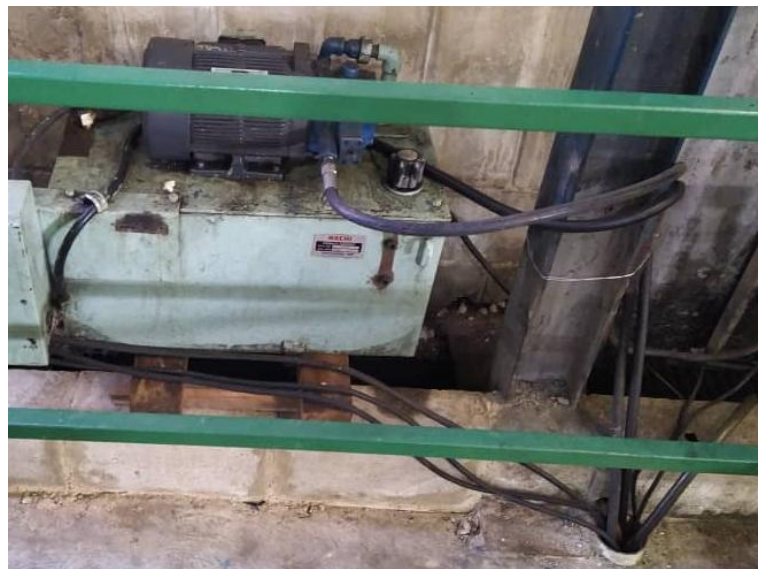
Figura 39: Motor AC de uso Hidráulico para el elevador
