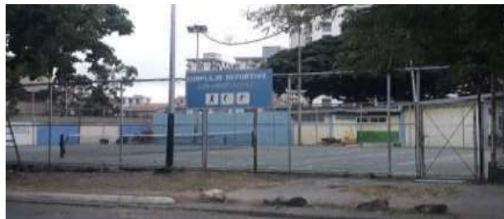
Figura 3. Resultado de la remodelación y construcción de la tercera cancha.
