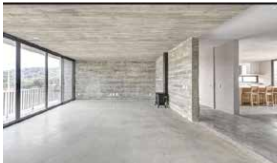
Figura 8. Acabado Concreto Pulido. (2018).
