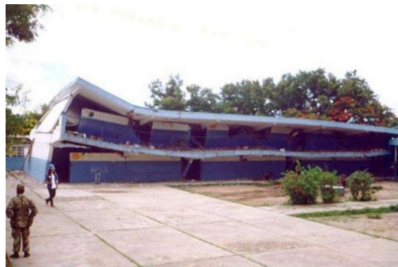
Figura 33: Módulo 2 Escuela Valentín Valiente, colapsada en el sismo de Cariaco 1997
