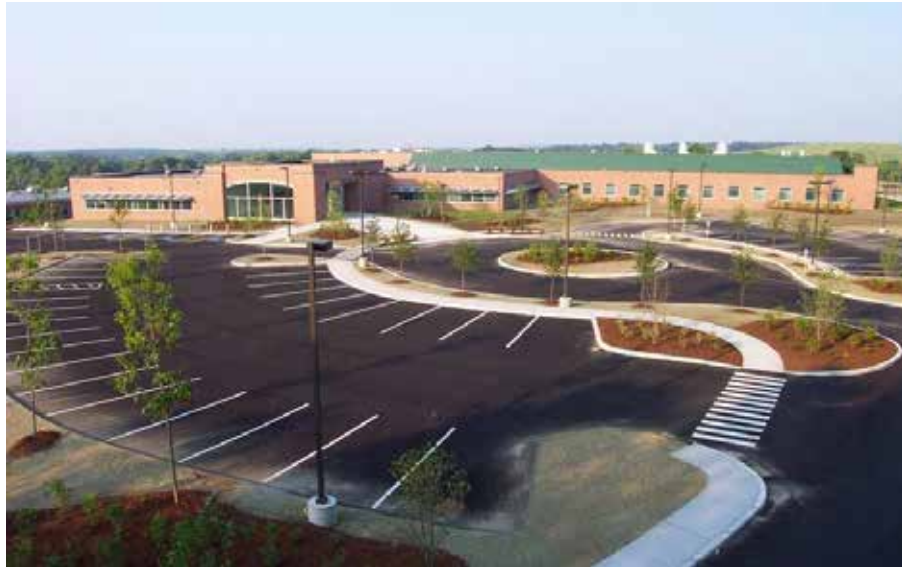
Figura 2. Laboratorio Del Ambiente En Nueva Inglaterra Fuente: http://www.wbdg.org/references/cs_nerlab.php (2010)
