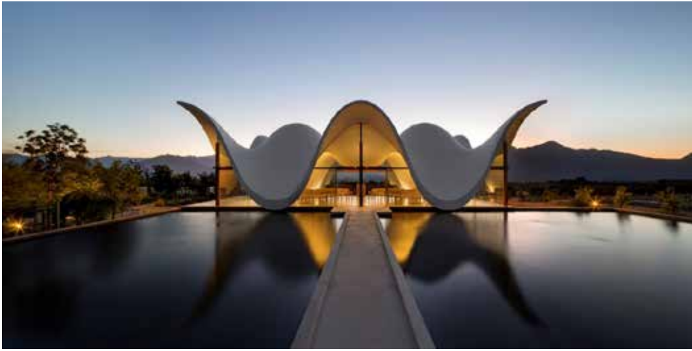
Figura 2. Vista Frontal de la Capilla Bosjes. Fuente: http://www.plataformaarquitectura.cl/cl/868343/capilla-bosjes-steyn-studio . (2017)
