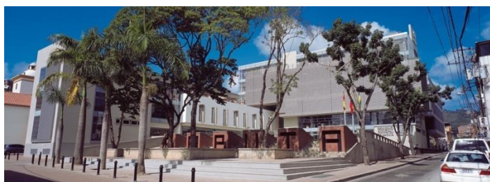
Figura 3. Vista Principal de la Sede de la Alcaldía de Baruta. Fuente: Mucucci y arquitectos asociados (2008).
