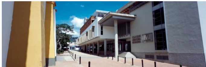
Figura 5. Vista del acceso del Concejo Municipal de la Sede de la Alcaldía de Baruta. Fuente: Mucucci y arquitectos asociados (2008).
