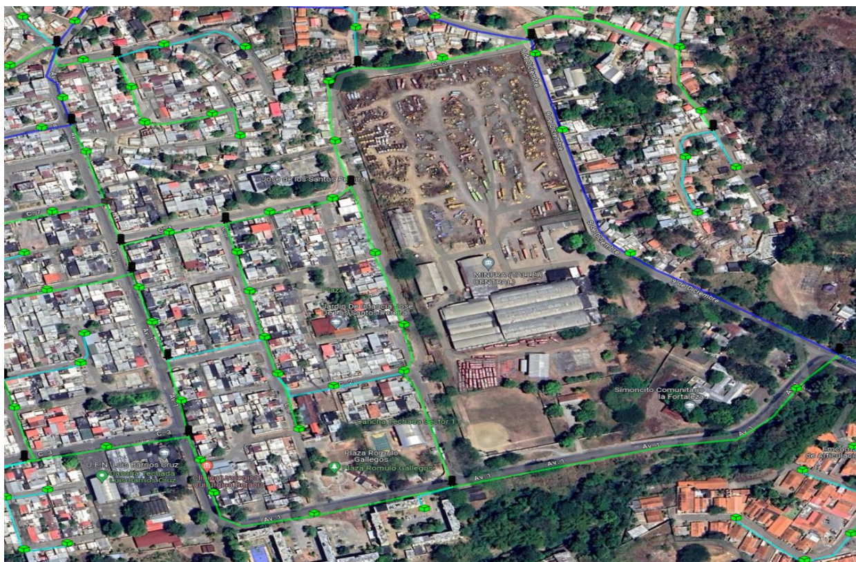
Figura 155. Red de fibra óptica B. Rómulo Gallegos parte 1. Fuente: Ramírez, Lugo. (2023)
