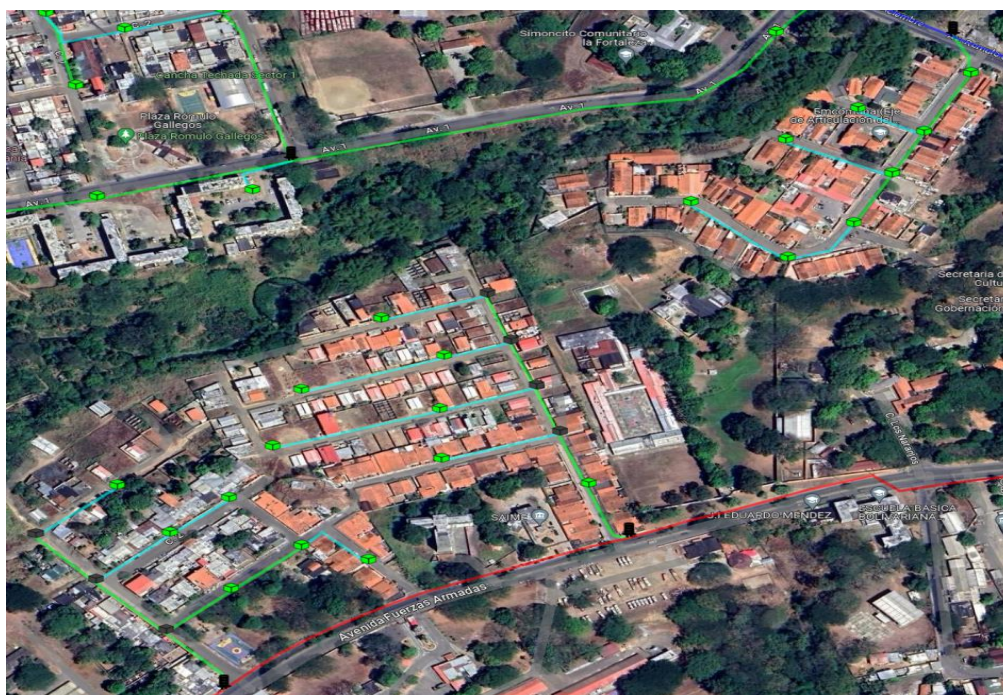
Figura 157. Red de fibra óptica Urb. Evaristo Linares Vega. Fuente: Ramírez, Lugo. (2023)
