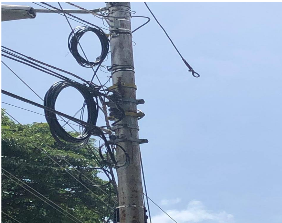
Figura 25. Arreglo de tendido de Fibra Óptica con soportes, flejes, hebilla, preformado. Av. Miranda. Fuente: Ramírez, Lugo. (2023).
