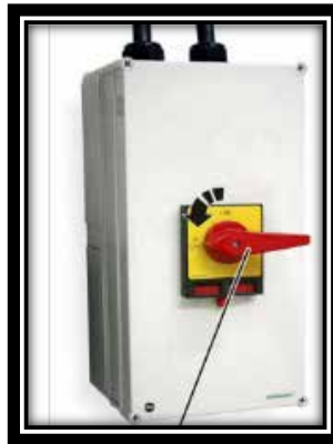
Figura 15: Instalación Eléctrica De Las Grúas Tipo Puente FUENTE: Herdé A, Zarate J (2021)
