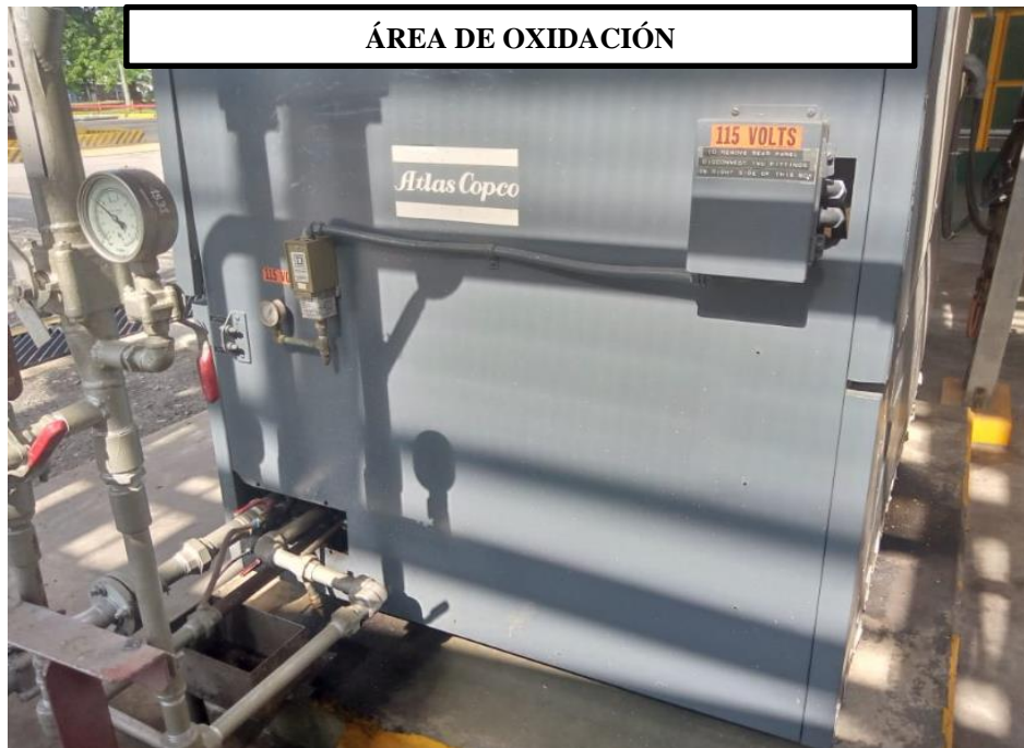
Figura 6 Compresor de Instrumentos 2131 Autor: Jaimes, A. (2023).
