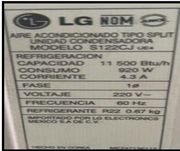
Figura 7: Unidad Condensadora Fuente compresores LG
