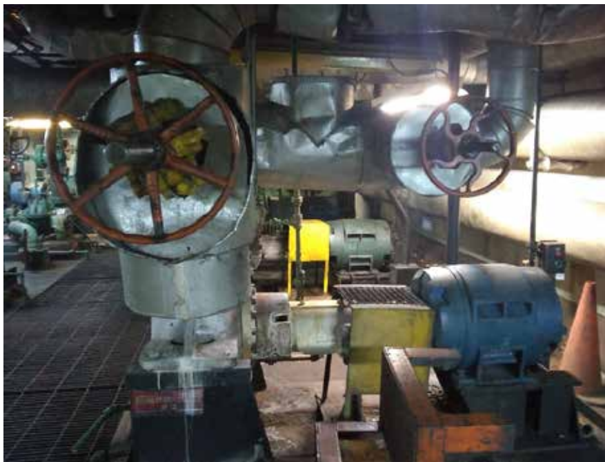
Figura 13. Bomba Spacemaker Motor para aguas calientes.
