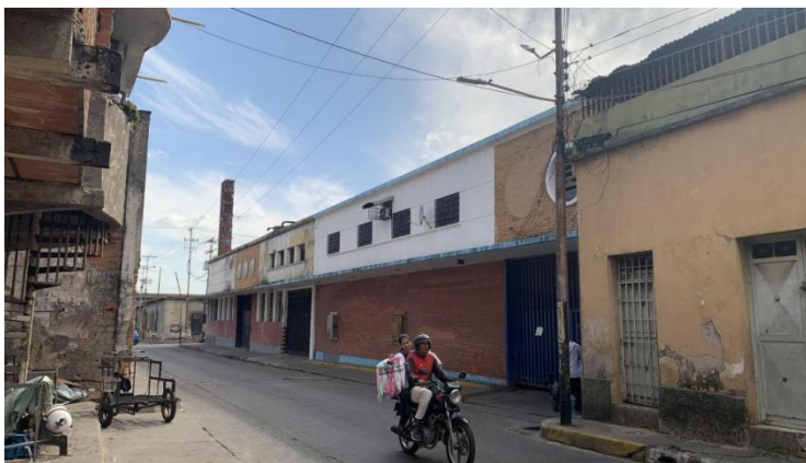
Figura 16. Av. 102 Montes de Oca
