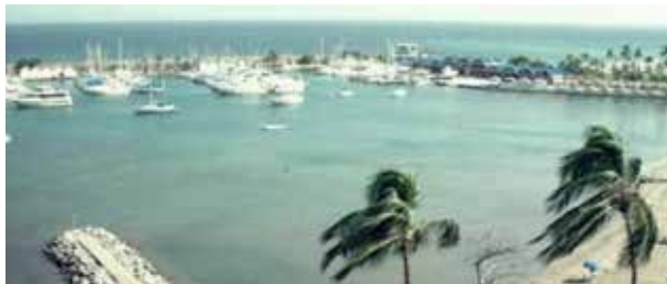
Figura 5. Vista del muelle para lanchas, veleros, Club Puerto Azul. http://issuu.com/rafaelterreroarquitecto/docs .
