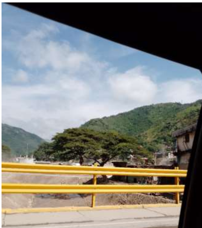
Figura 14: Quebrada Los Patos vista desde la carretera Panamericana
