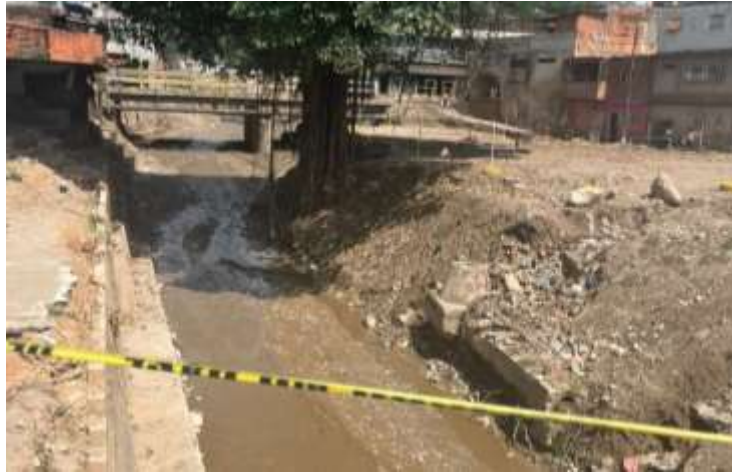
Figura 2: Quebrada Los Patos, vista desde la calle Miranda.
