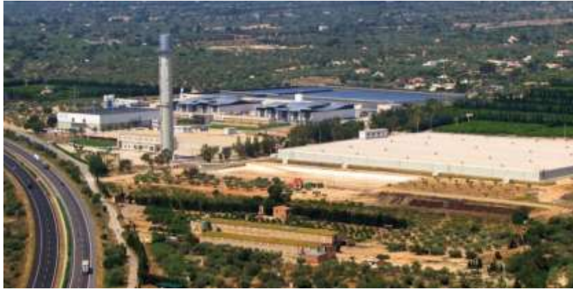
Figura 10: Planta Potabilizadora de l'Ampolla (España)
