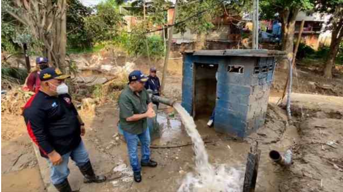
Figura 3: Recuperación de pozos en el Casco Central de Las Tejerías, estado Aragua.
