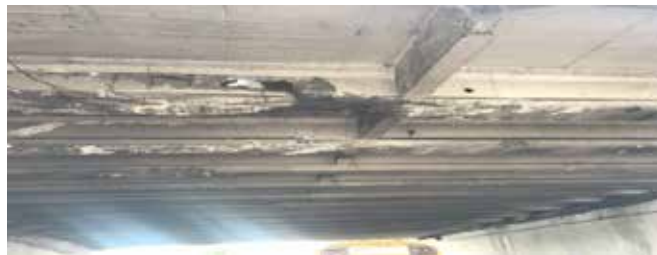
Figura 43: Armadura inferior de la viga
