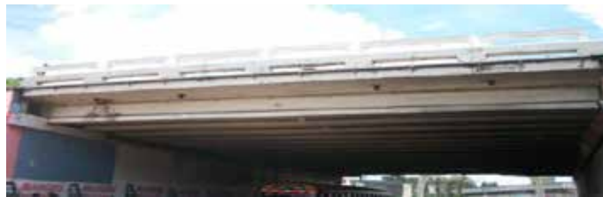
Figura 28: Vista de vigas “5-15”
