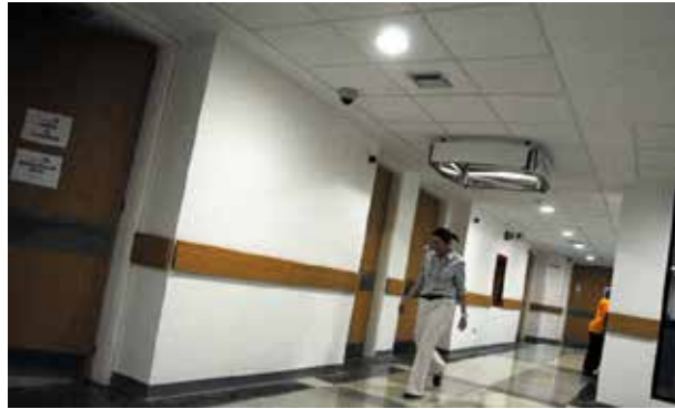
Figura 22 Barandas Emergencia: El Autor (2014)
