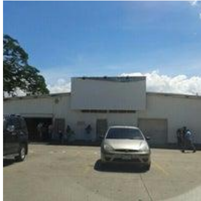
Figura 10. Fotografía del edificio de la planta.
