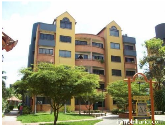
Figura 11. Fachada del Conjunto Residencial Poblado de San Diego. Fuente: La Autora (2002)
