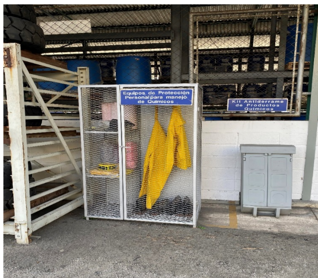
Figura N°11: Kit anti derrame y Equipos de Protección Personal (EPP) de la Cervecería Polar, Planta San Joaquín en almacén de químicos Autor: Galarraga (2024)
