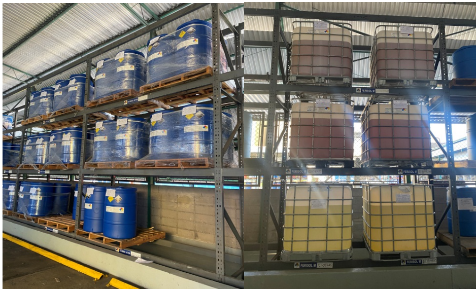
Figura N°4: Almacenamiento de productos químicos en Cervecería Polar, Planta San Joaquín Autor: Galarraga, (2024)
