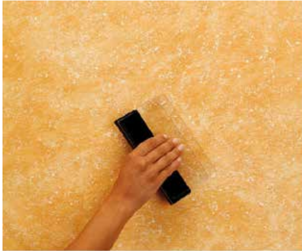
Figura 22: Acabado de paredes en yeso. . Fuente: http://www.arqhys.com/wp-content/fotos/2013/11/Acabados-para-paredes.jpg (2016)
