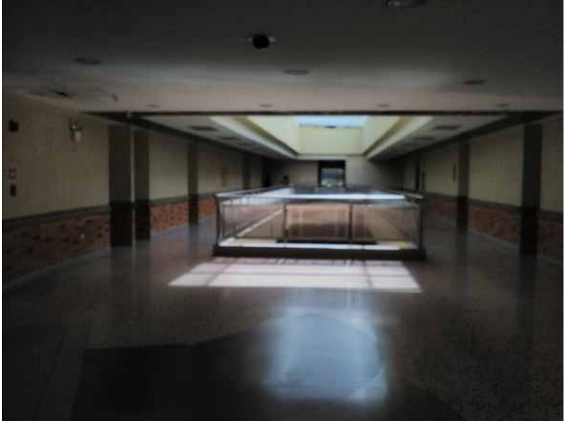
Figura 3: 5to Piso del edificio de estudios múltiples
