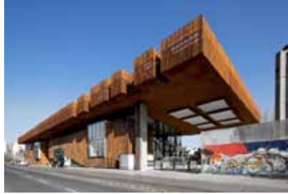
Figura.4. Fachada Centro Cultural Gabriela Mistral. Fuente: plataformaarquitectura.cl (2008)
