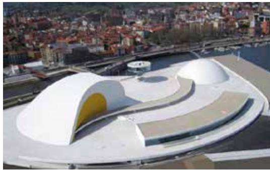
Figura 2. Vista aérea del Centro Cultural Internacional Oscar Niemeyer. Fuente: http://www.niemeyercenter.org (2011)
