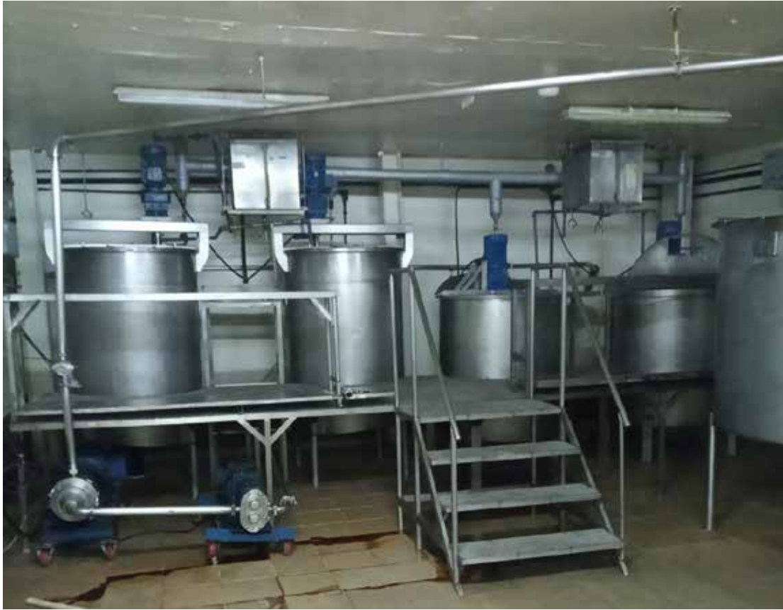
Figura 10. Sala de preparación 1.
