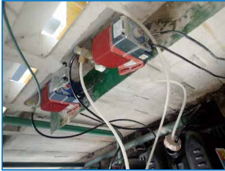
Fig. 18 Proceso de desoxigenación del agua en las calderas Fuente: Hernández (2019).
