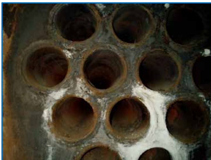
Fig. 27 Tuberías internas de la caldera 2
