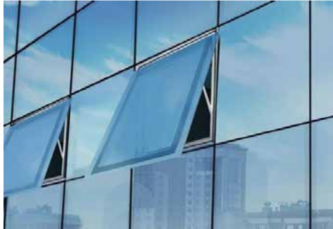
Figura 22. Curtain Wall. Corporación Corrales (2002).
