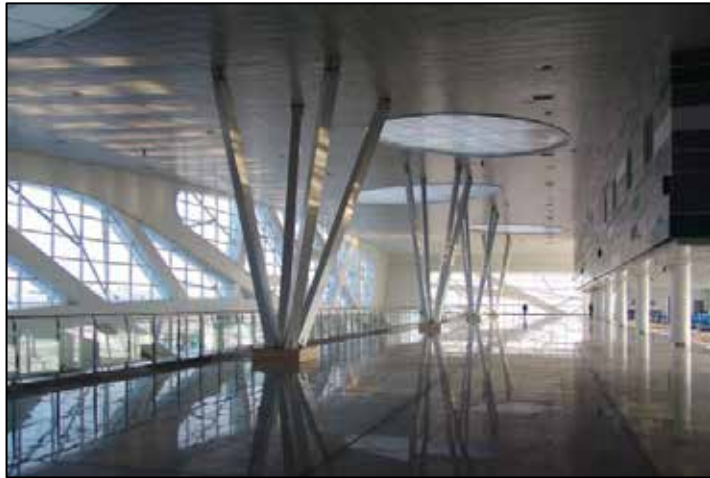
Figura 39. Estructura de columnas árbol
