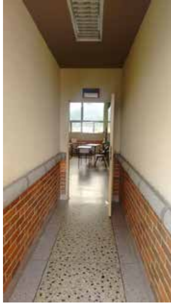
Anexos 3. Fotografía de la inspección.
