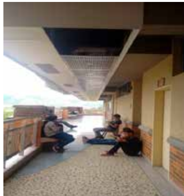
Anexos 2. Fotografía de inspección.
