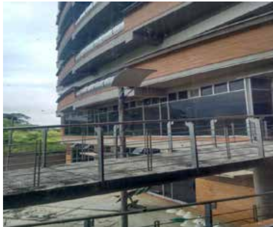
Anexos 1. Fotografía de la inspección.
