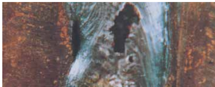
Figura 7. Fusión Incompleta en la superficie de la Ranura.
