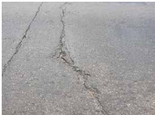
Figura 14: Grietas Transversales.
