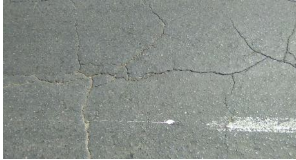
Figura 10: Falla Longitudinal.
