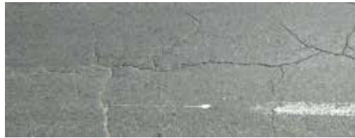
Figura 37: Falla Longitudinal.
