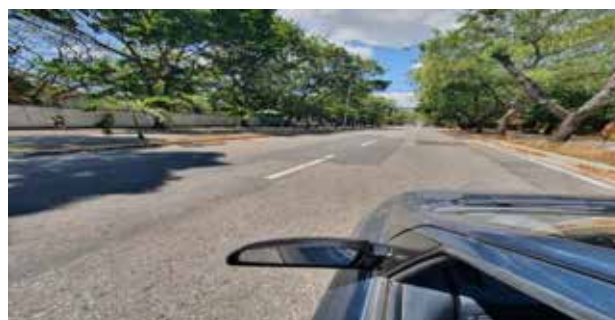
Figura 30: Área Parchada en el Tramo 7.
