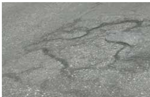
Figura 26: Huecos en el Tramo Parcial 6.
