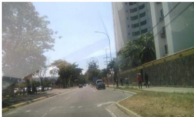
Figura 23: Canal de Desincorporación.
