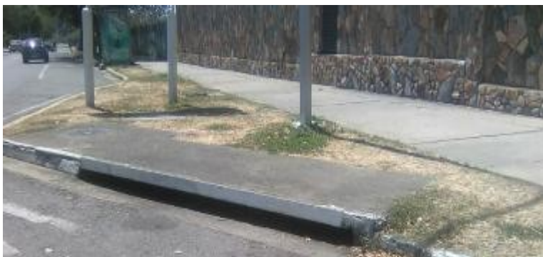
Figura 24: Drenaje Libre de Obstrucciones.
