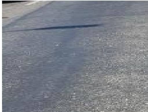
Figura 20: Exudación a un Grado Ligero.
